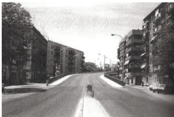
El desaparecido puente de la calle Oriente a finales de los setenta.
